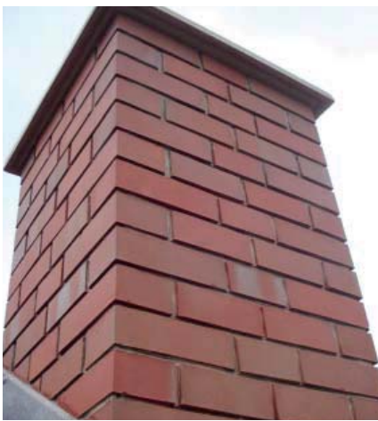
Použití lícovek při stavbě komínů - německý formát červená melír.
