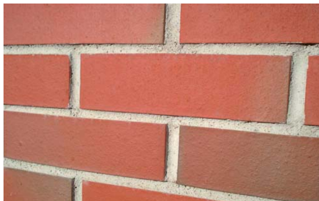
Příklad spárování lícových cihel německý formát - červená melír
