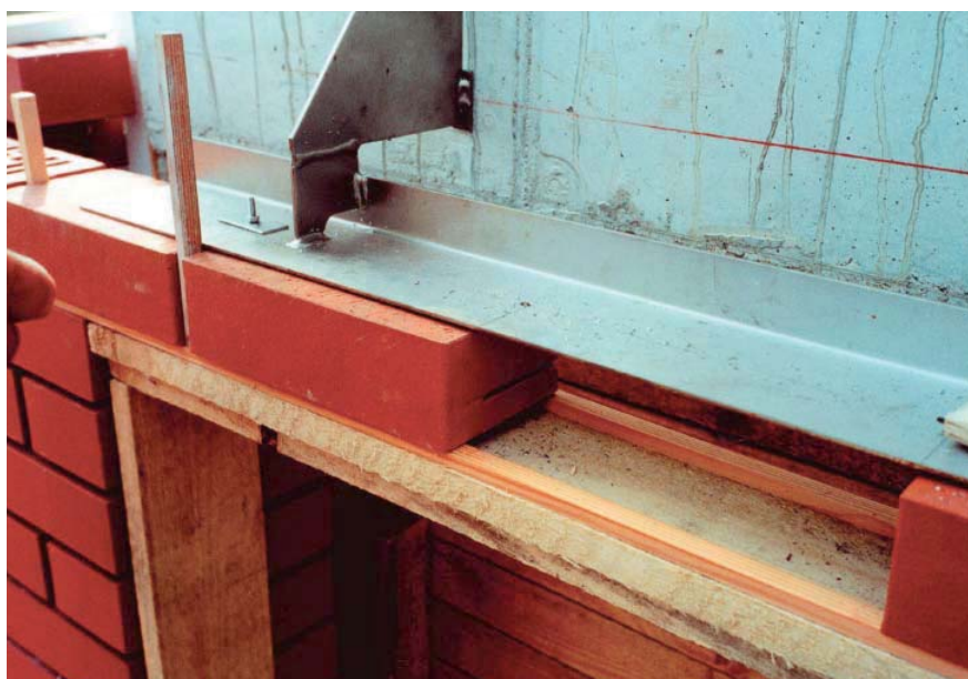
Příklad použití úhelníkové konzolové kotvy typu HK4-FV
