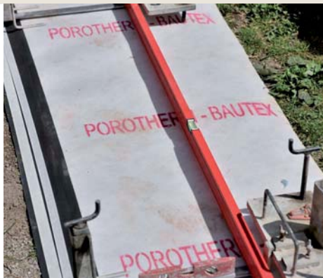
7.1.2 Proti vztlínání vlhkosti se pokládá v místě budoucí vyzdívký hydroizolační fólie (např. Porotherm ZIP - S).
