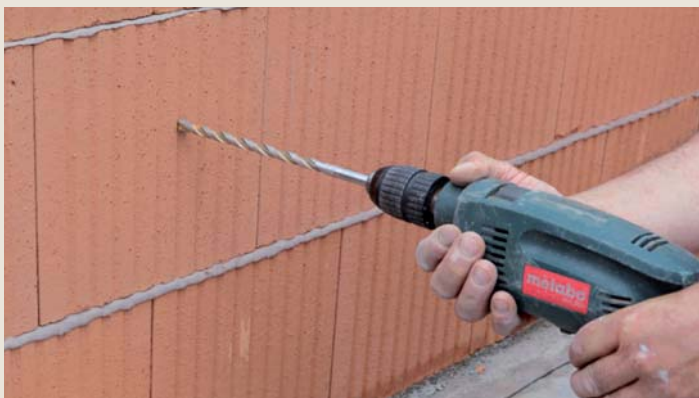
7.11.4 Vrtání bez přiklepu s ostře nabroušeným vrtákem z tvrdokovu.
