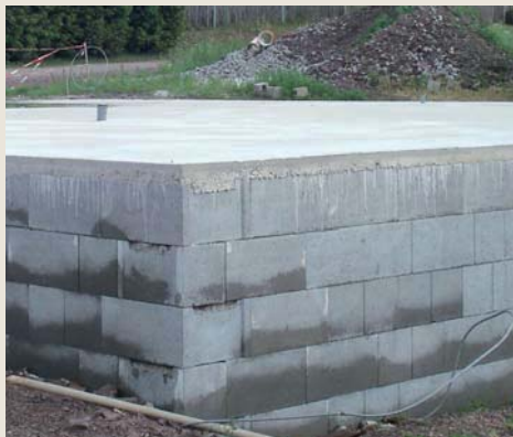
7.1.1 Připravená základová deska pro zdění obvodových cihel Porotherm T Profi.
