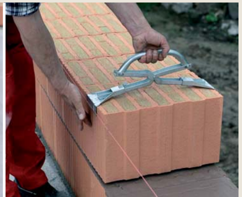
7.3.6 Jako obvykle umístíte na začátku a na konci řady jednu cihlu a k nim přiložíte zednickou šňůru. Potom pokládejte cihly na sraz tak, aby byl při spuštění do vrstvy malty slyšet jejich skřípot.
