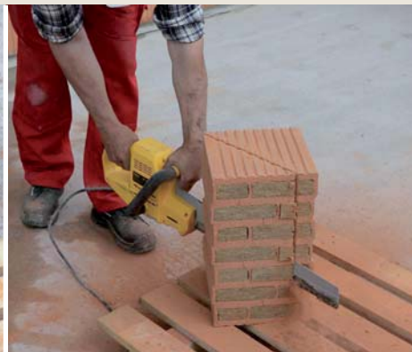
7.8.6 Suché řezání elektrickou ruční pilou.
