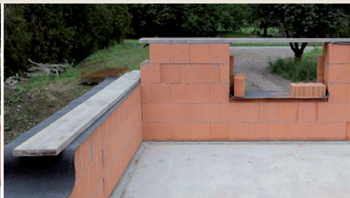
7.13.2 Zakrýtí musí být ochráněno proti účinkům větru.
