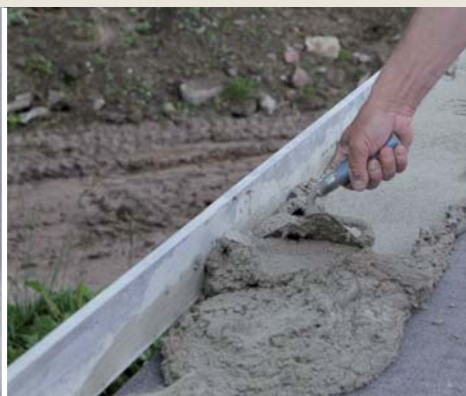
7.1.6 Malta se rozprostře zednickou lžící.
