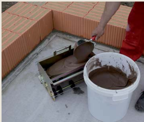
7.3.4 Nyní se maltovací vozík naplní maltou pro tenké spáry.
