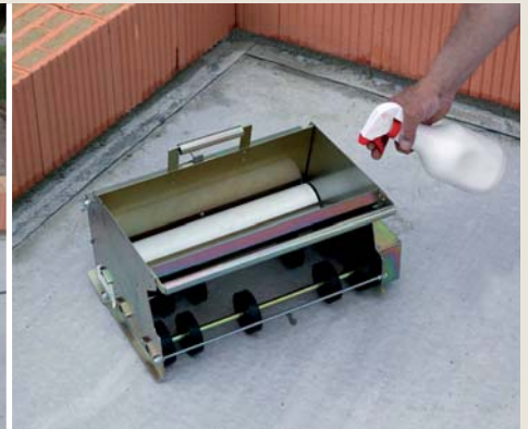
7.3.3 Maltovací vozík před prvním plněním nastříkat tenkou vrstvou separačního prostředku. To usnadní pozdější čištění.
