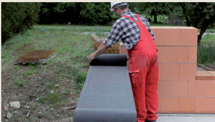
7.13.1 Po ukončení práce zakrýt všechny koruny zdí.
