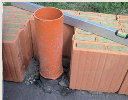
7.12.3 První vrstva cihel Porotherm 44 T Profi u vyzdívané drážky pro odpadní potrubí.
