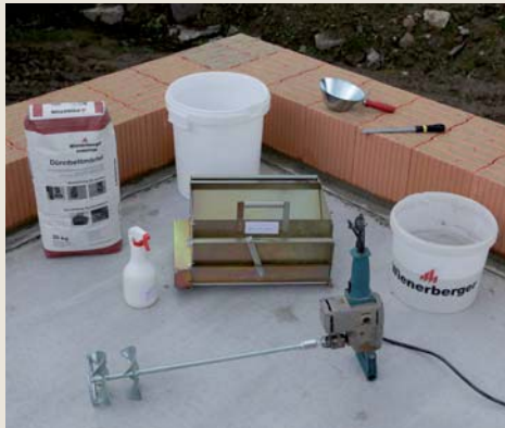
7.3.1 Potřebný materiál (podle programu produktů Wienerberger): tenkovrstvá malta, čisticí sprej (separační prostředek), vědro pro rozmíchání, maltovací vozík, vědro na vodu, mísidlo, fanka, pilník.
