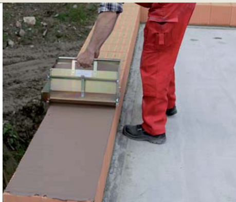
7.3.5 Maltovací vozík nasadit na rohu a bez tlaku táhnout přes cihly. Takto se tenkovrstvá malta nanese na horní plochu cihel rychle a jednoduše.
