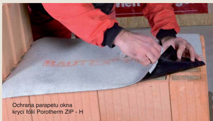
7.13.2 Zakrýtí musí být ochráněno proti účinkům větru.
