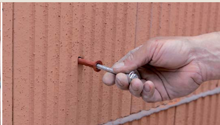
7.11.5 Vsunutí hmoždinky (popř. již se šroubem) do vyvrtaného otvoru.
