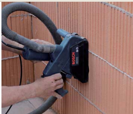
7.11.2 ... svislé drážkování pro elektrické rozvody.
