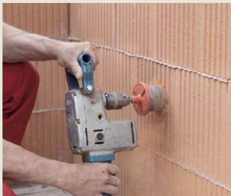
7.11.1 Vrtání kruhovým děrovačem a ...
