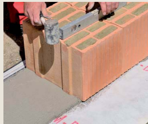
Pokládka cihel Porotherm 38 T Profi na fólii Porotherm ZIP - S
