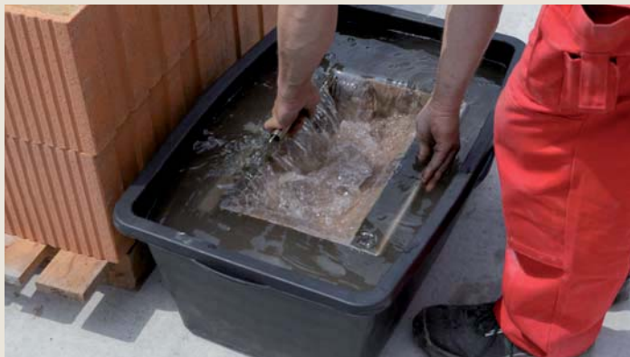
7.3.7 Během delších přestávek v práci položte prázdný vozík do vodní lázně. Tak malta na něm nezaschne. Pokud se má opět pokračovat, vodu z maltovacího vozíku jednoduše vytřeste.
